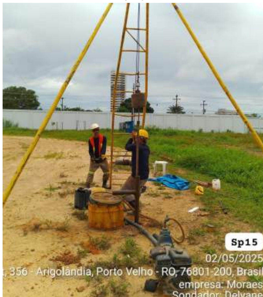
Instalação do furo SP-15
