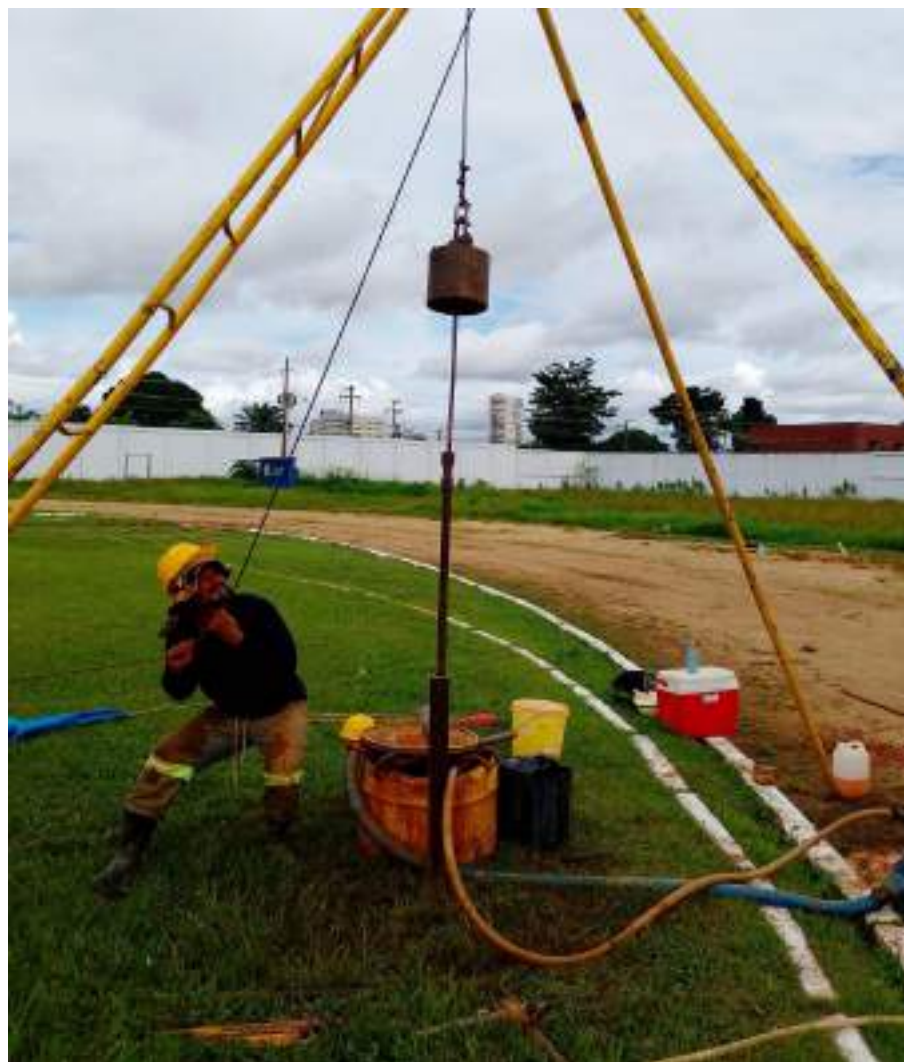
Instalação do furo SP-16 A
