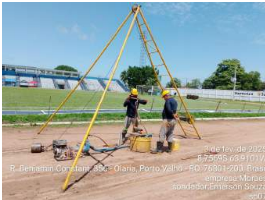
Instalação do furo SP-07
