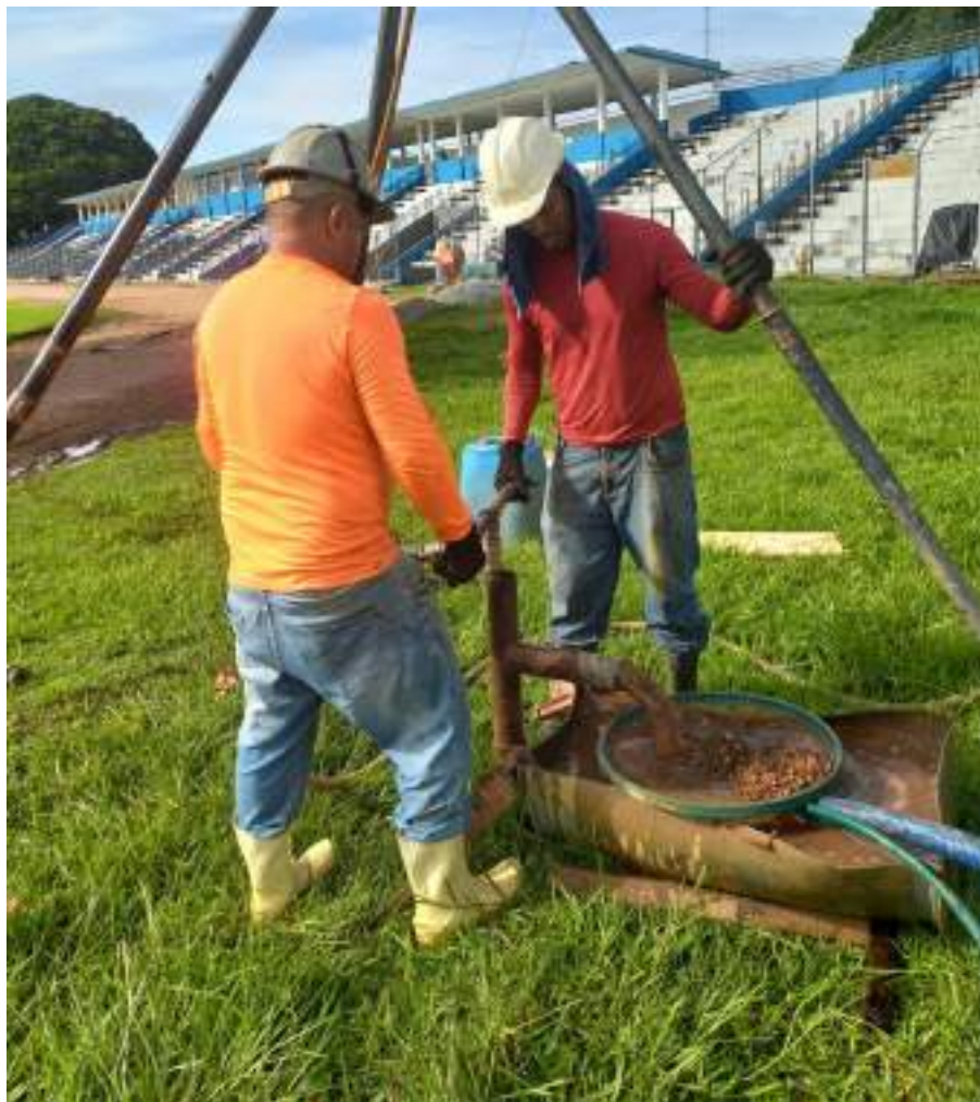
Instalação do furo SP-01
