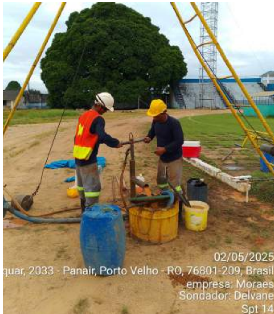
Instalação do furo SP-14 A
