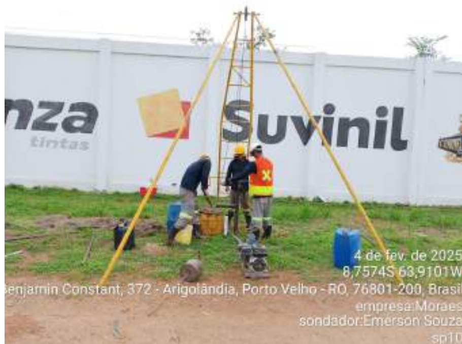
Instalação do furo SP-10
