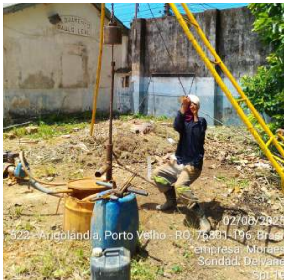
Instalação do furo SP-19
