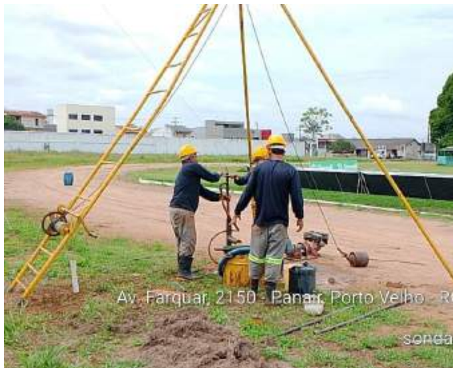
Instalação do furo SP-10 A
