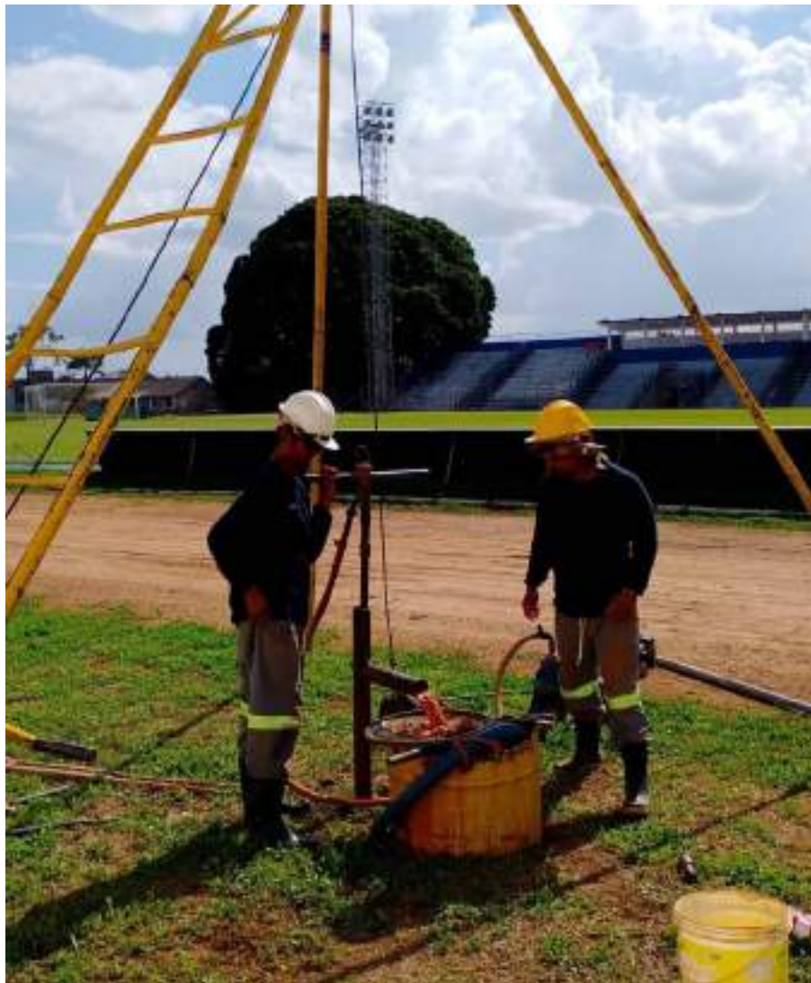
Instalação do furo SP-08 A
