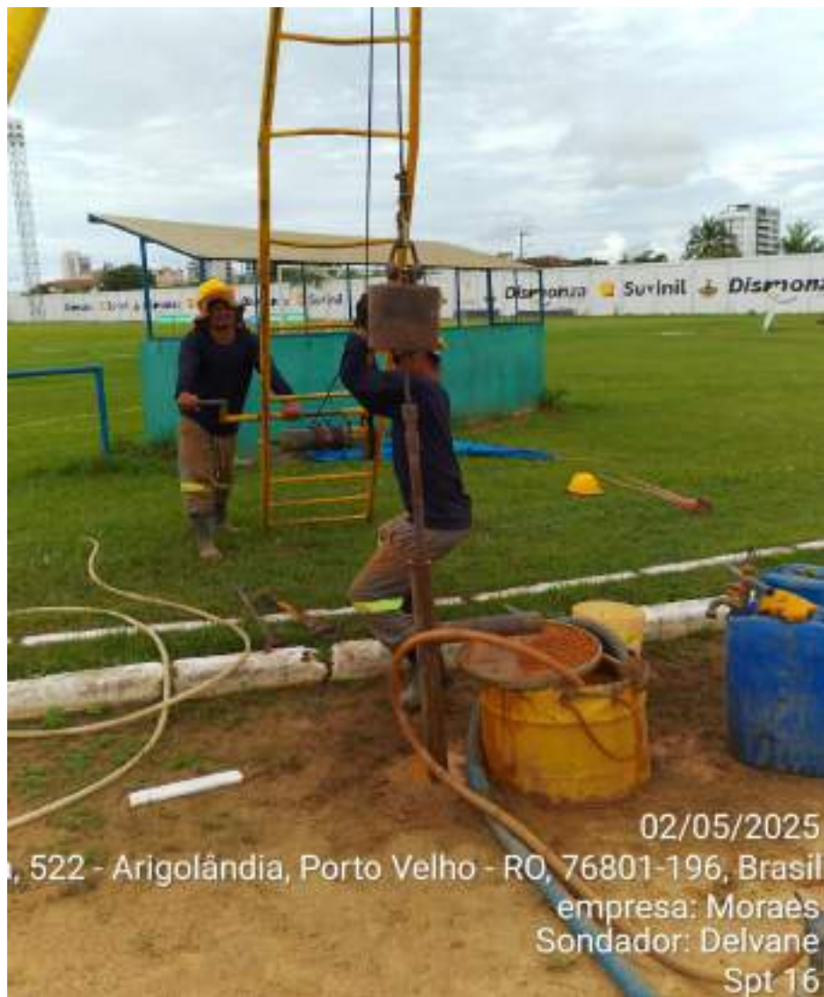
Instalação do furo SP-16
