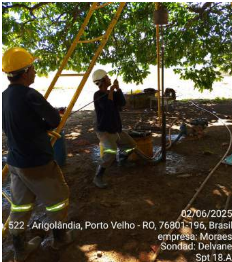
Instalação do furo SP-18 A
