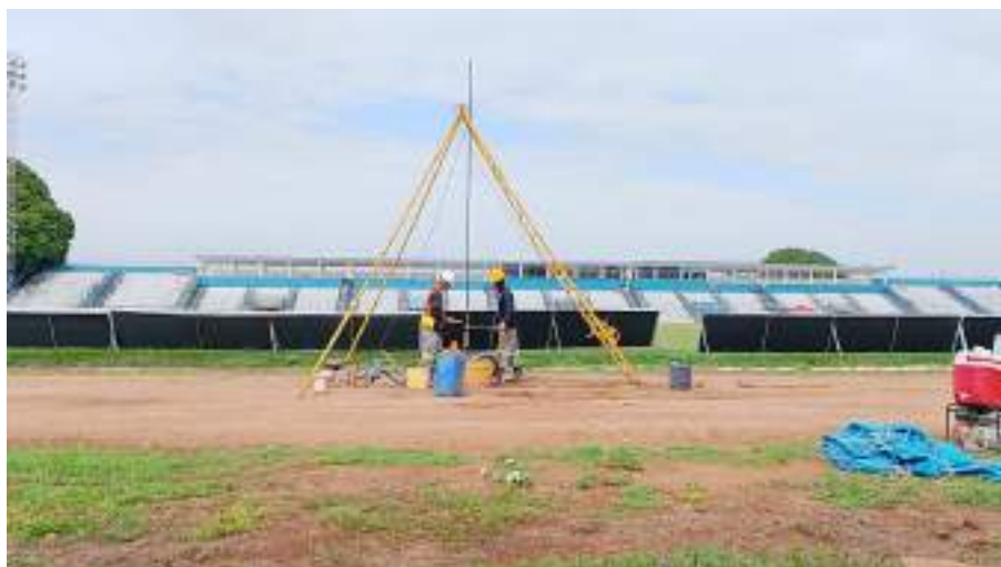
Instalação do furo SP-09 A
